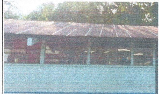
Foto 1: Mejoramiento de cubierta de lamina troquelada calibre 26 Modulo 1
